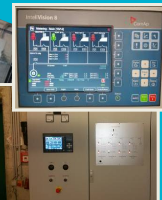
Projekt Traisenpark St. Pölten/ Österreich Umbau Aggregat und Steuerung. Aggregat mit elektronischer Regelung ausrüsten für Netzparallelbetrieb. Steuerung neu für 4 synchronisierfähige Umschaltgruppen
