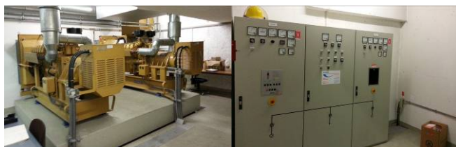
Altbestand aus 1975 vor der Demontage
