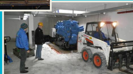
Projekt BMW Landshut (links) 2300kVA Einbringung Aggregat
