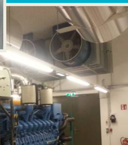
Projekt STAR 22 Wien NEA 2 x 2100kVA mit Tischkühlanlage und Raumventilatoren
