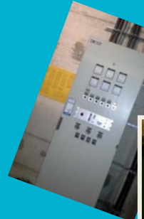
Projekt Traisenpark St. Pölten/ Österreich Umbau Aggregat und Steuerung. Aggregat mit elektronischer Regelung ausrüsten für Netzparallelbetrieb. Steuerung neu für 4 synchronisierfähige Umschaltgruppen
