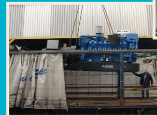
Projekt ADAC München 1 x 2100 kVA 1 x 1750 kVA Einbringung Aggregat Nr1
